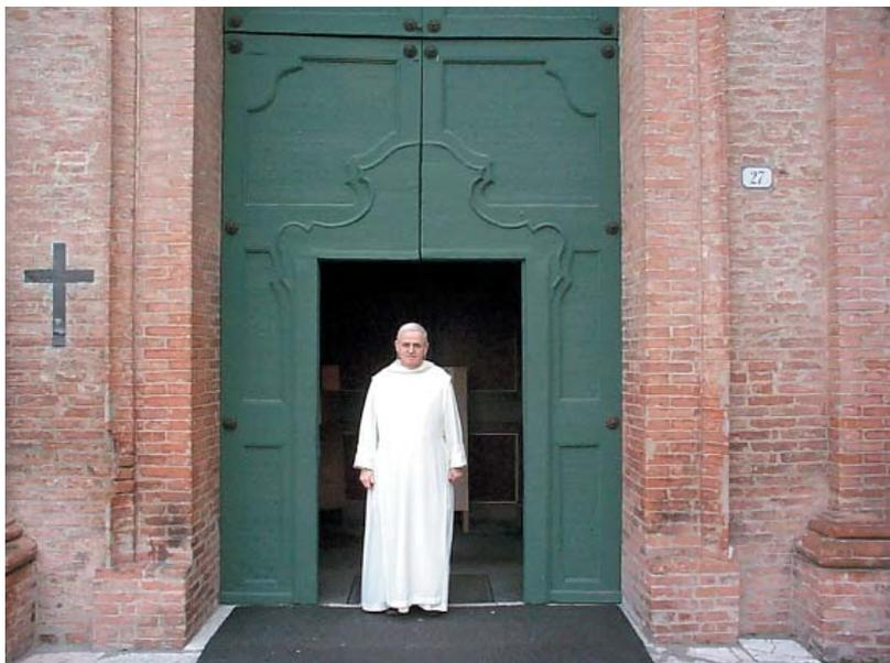
nella zona di San Giorgio. Nel restauro è stata rimossa la vernice deteriorata; si è consolidata la parte inferiore; sono stati stuccati buchi e crepe; il portone è stato verniciato con una tempera opaca e infine sono state pulite le chiodature e le rosette decorative. Il restauro è stato eseguito sotto la direzione di Maria Grazia Gattari della Soprintendenza per i Beni Artistici e Storici di Bologna, Ferrara, Forlì, Ravenna, Rimini e con la collaborazione dell'architetto Salvatore Fazio.
